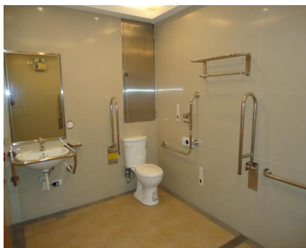
於廁所牆壁安裝扶手
