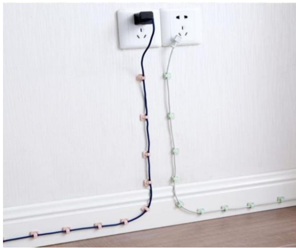
將電線固定在牆角邊
